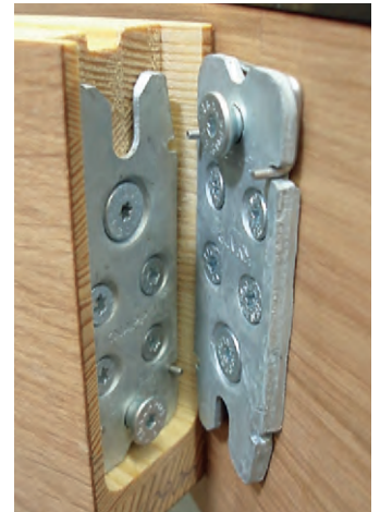
▲ Der Knapp-Verbinder „Ricon“ hält die Fassade zusammen
