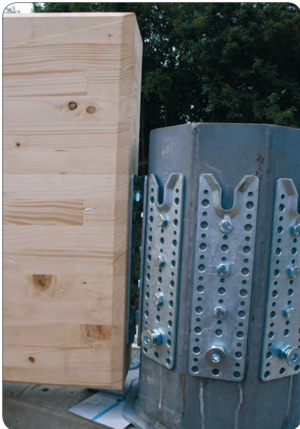
Ein polygonförmiger Stahlrohrabschnitt mit ringsum aufgeschraubten Trägerplatten der RICON® S-Verbinder schließt die Bögen im höchsten Punkt der Kuppel zusammen. Sie wurden einfach rundum eingehängt.
