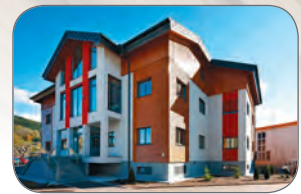
Bürogebäude StoraEnso (A)
