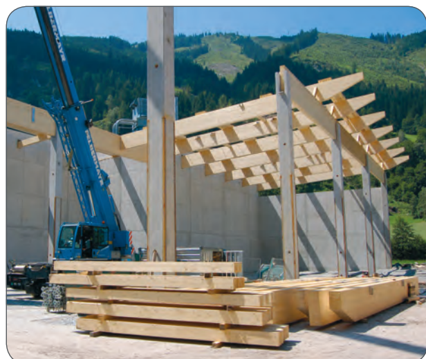
■ Warten auf Abruf: Vormontierte Binder für die Lagerhalle.
