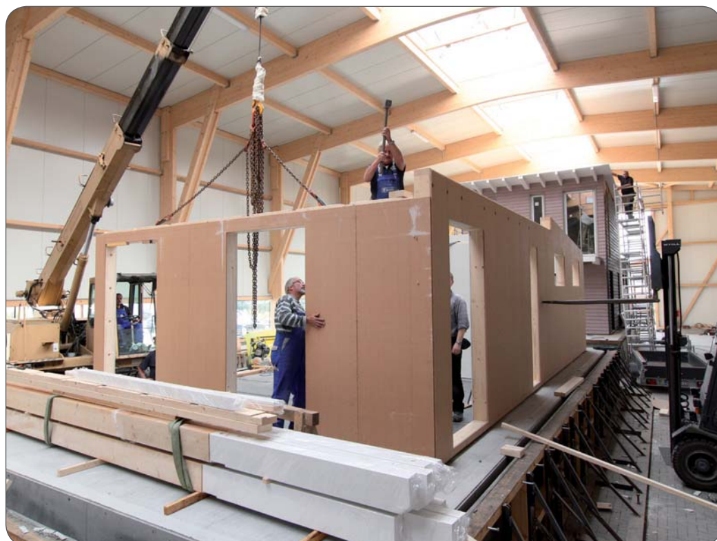
Ein Mobilkran hebt in der Yachthafen Halle die angelieferten Elemente zur Montage in ihre Position.
