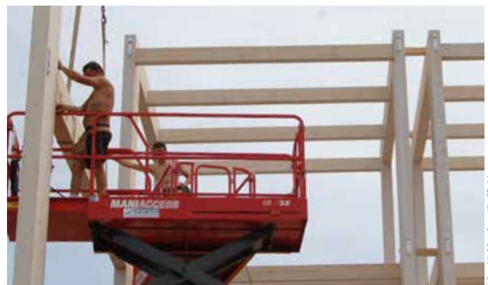
Einbau des Nebenträgers mit Stütze mittels RICON®S
