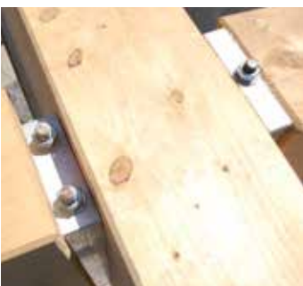
Oben bündiger beidseitiger Haupt- und Nebenträger MEGANT® Anschluss.
