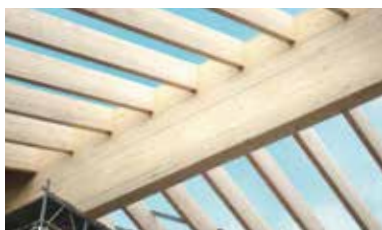
Hallendach mit RICON® S Firstanschluss Zimmerei S. Hinrichsen (DE)
