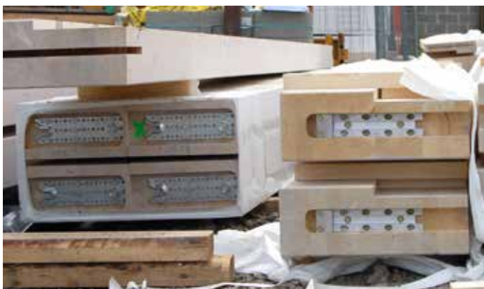
RICON® S dreiseitig im Nebenträger eingefräst
