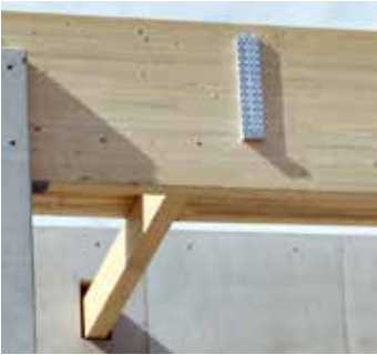
Bei nur 2 cm Einhängeweg kann eine Montage in Ausnehmungen von Betonwänden erfolgen.
