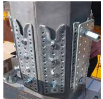
Firstknoten für Kuppeldach
