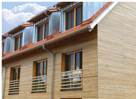
Vorgehängte Fassaden sicher einhängen.
