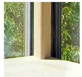
■ Ecke von innen mit Design-Pfosten (Glas Bau Creativ).
