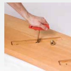
1) Einschraubmutter anschrauben (SW 10)
