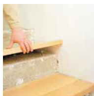
3) Bohrungen übertragen
