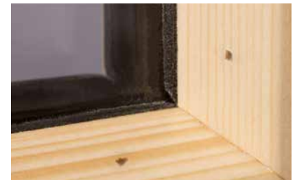
Herkömmlich befestigte Glasleiste mit sichtbaren Nägeln.
