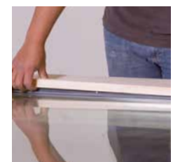
4) Einclipsen der Glasleiste
