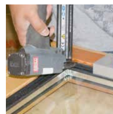
3) FIXclip-Schiene verschrauben oder nageln
