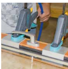
2) Scheibe gegen Außen-dichtung anpressen
