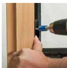
2) FIXclip GLE20 schräg verschrauben
