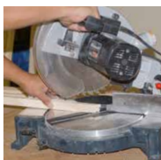
1) Glasleiste und FIXclip-Schiene zuschneiden
