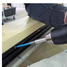
2) FIXclip-Schiene verschrauben
