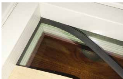
Montagebeispiel: Einbringen der Keildichtung
