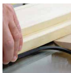
4) Keildichtung einpressen
