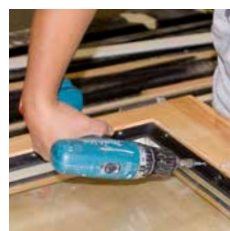
3) FIXclip-Schiene verschrauben oder nageln
