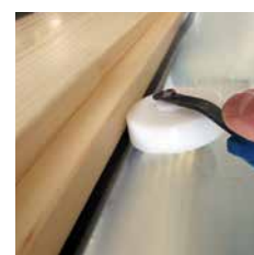
5) Leichte Verarbeitung mit Dichtungsroller
