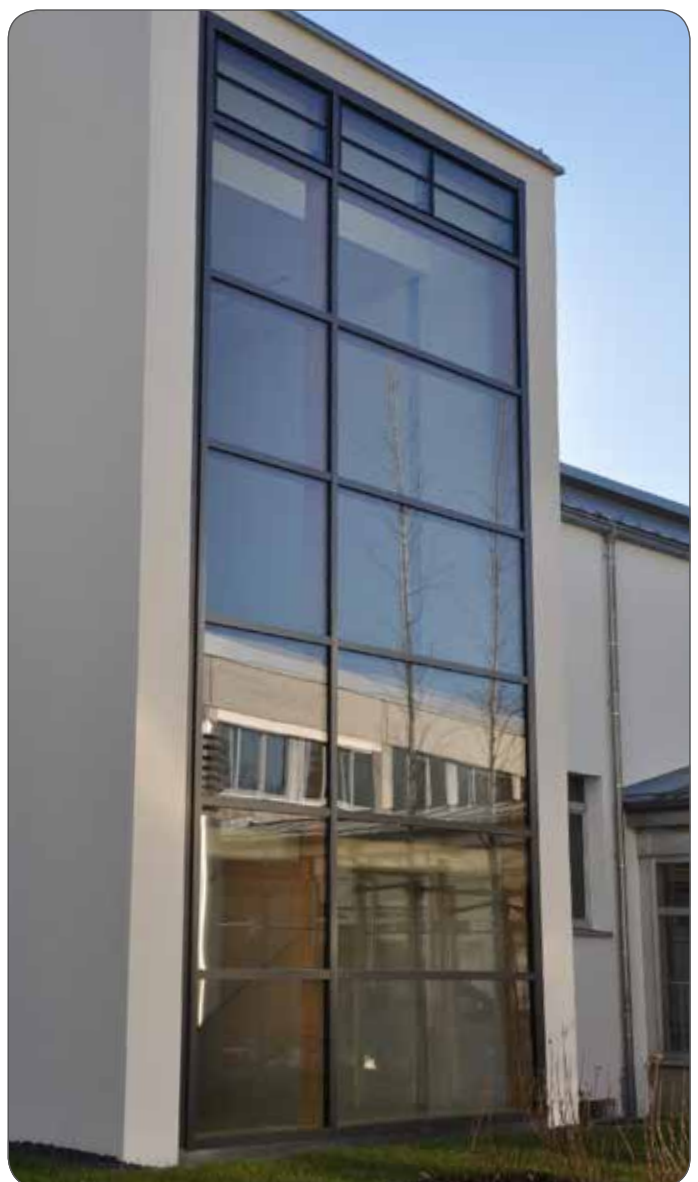
■ Für eine perfekt Optik wurden bei der Fassade in Feldkirchen filigrane Konstruktionen eingesetzt.
